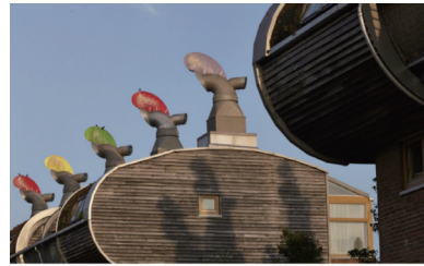
<그림 5> 베드제드 환기구 (출처 : 탄소제로 주거단지, 영국 베드제드)
